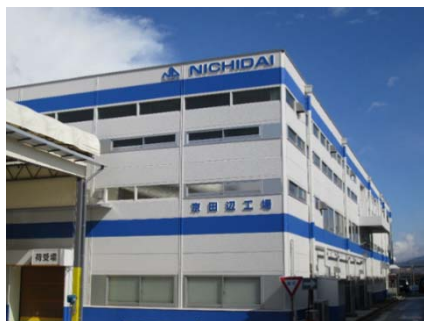
京田辺工場 京都府京田辺市
